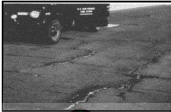
Gambar 2.2 Jenis Kerusakan Retak Blok
